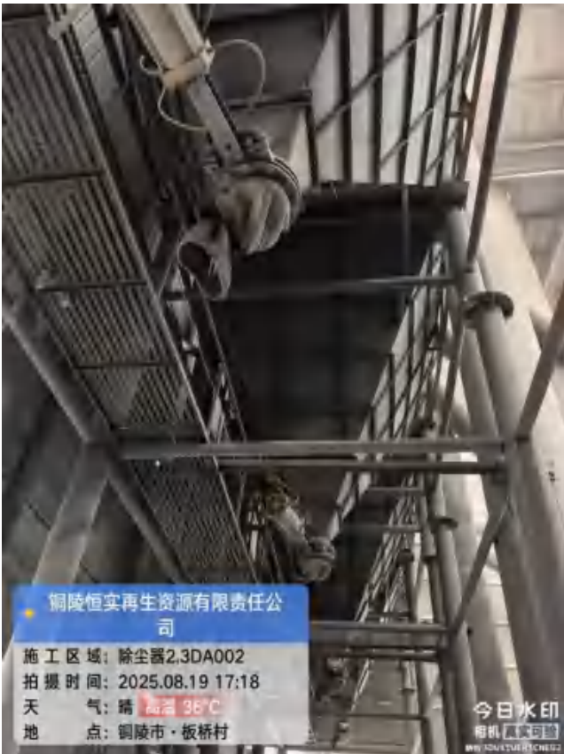
图 3.1.2-5 并联高效除尘器（TA002、TA003）
